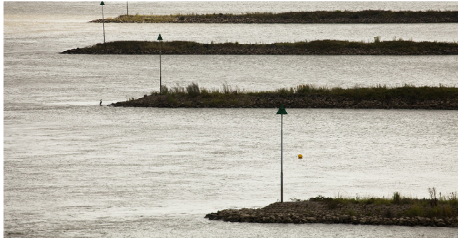
Perpendicular groynes in the Waal river (source: https://beeldbank.rws.nl, Rijkswaterstaat, Ruimte voor de Rivier )
